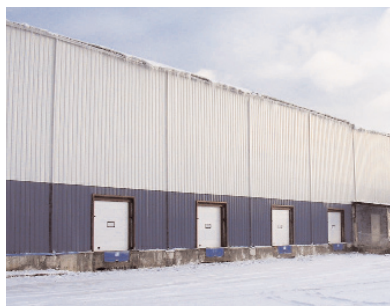
Складской комплекс в г. Видное
